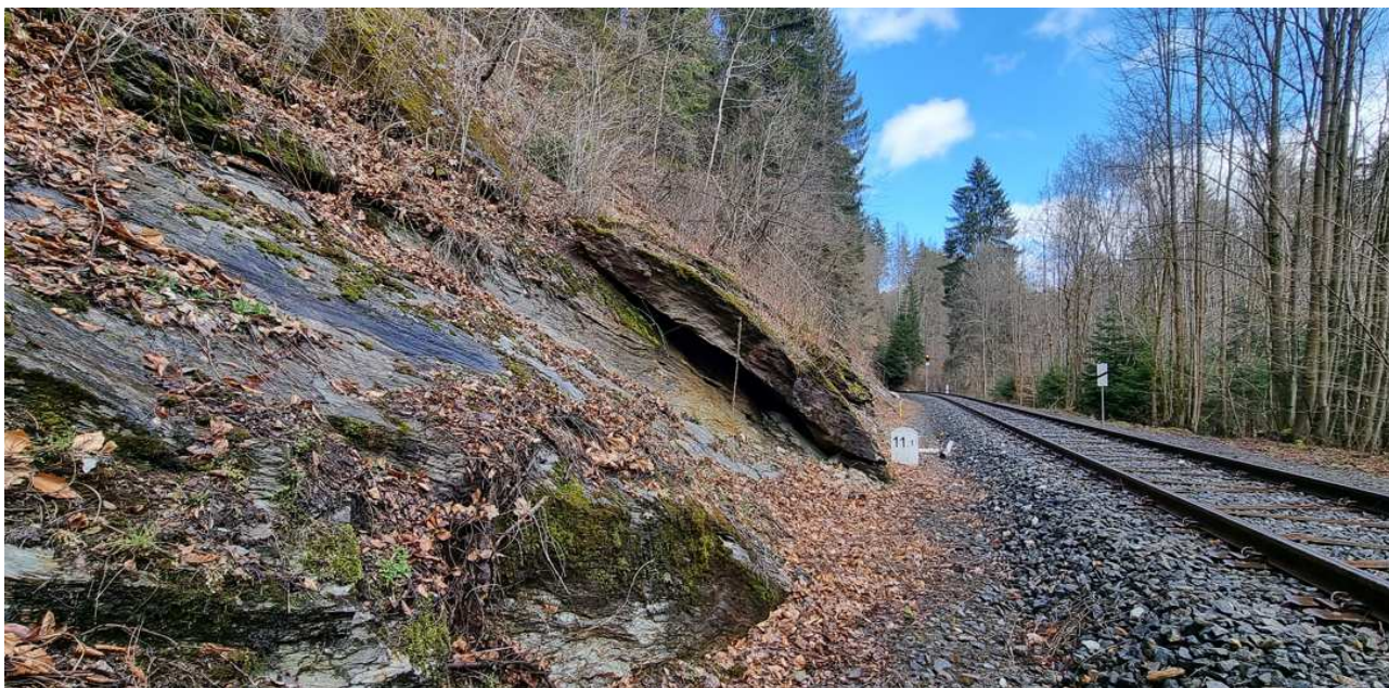
Příklad mechanismu porušení v předmětném úseku, km 11,1
